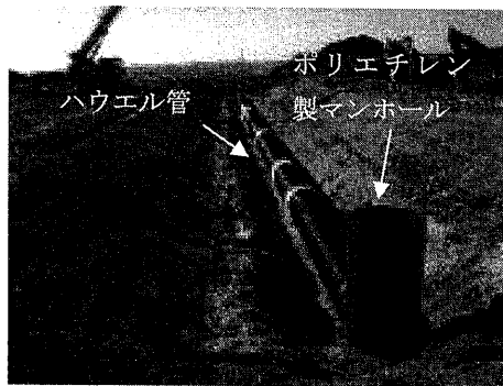
写真-7.4.1 据付状況
