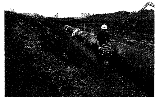
写真-2.5.3 埋戻し，転圧状況
